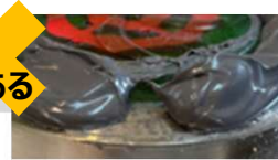
床へ設置後、接着剤が治具からはみ出している
